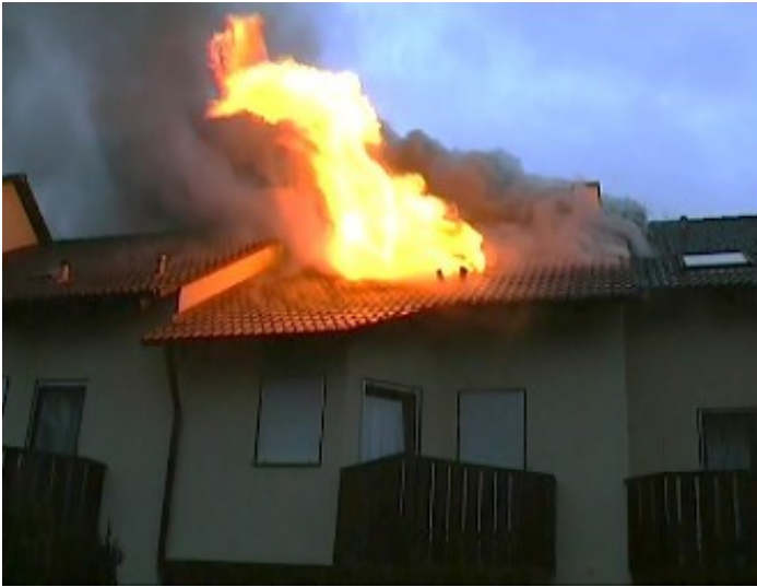
Lage kurz nach dem Eintreffen. Das Dachgeschoß eines Reihenhauses brennt in voller Ausdehnung. Flammen schlagen aus einem Dachliegefenstern.
